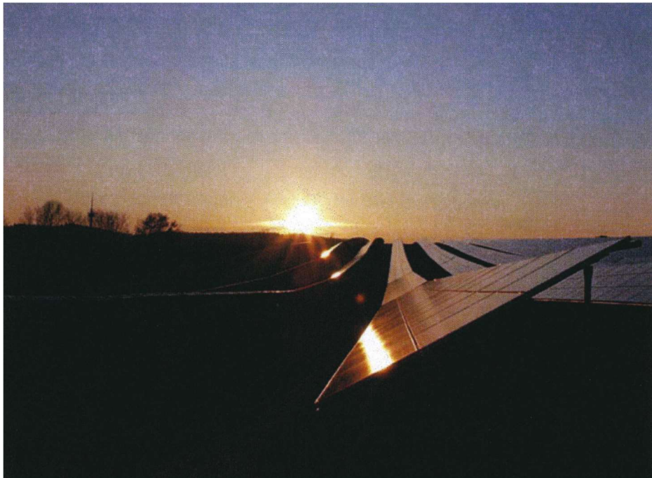
Abb. 2: Blendungssituation bei streifendem Lichteinfall gem. [5]
