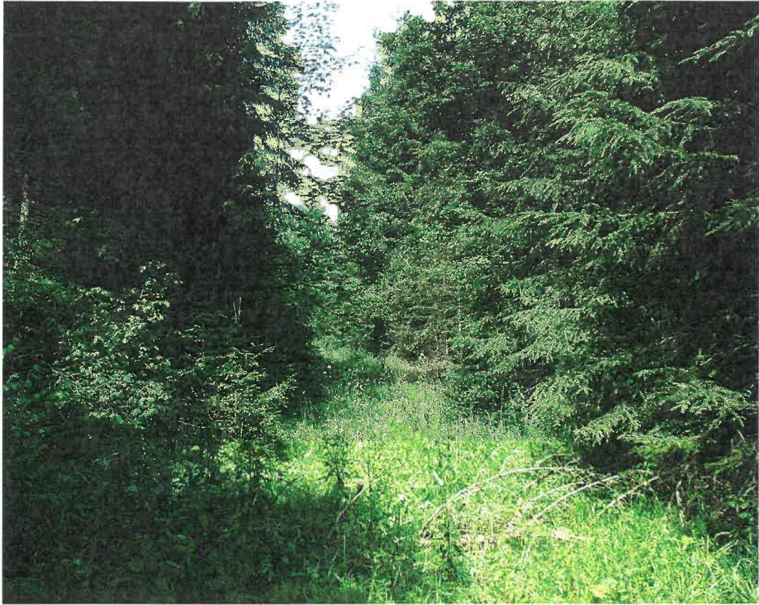
Bahndamm im Fichtenforst, zunehmender Bewuchs durch Fichte
