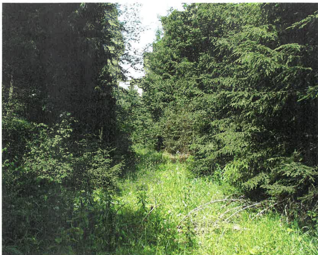
Bahndamm im Fichtenforst, zunehmender Bewuchs durch Fichte
