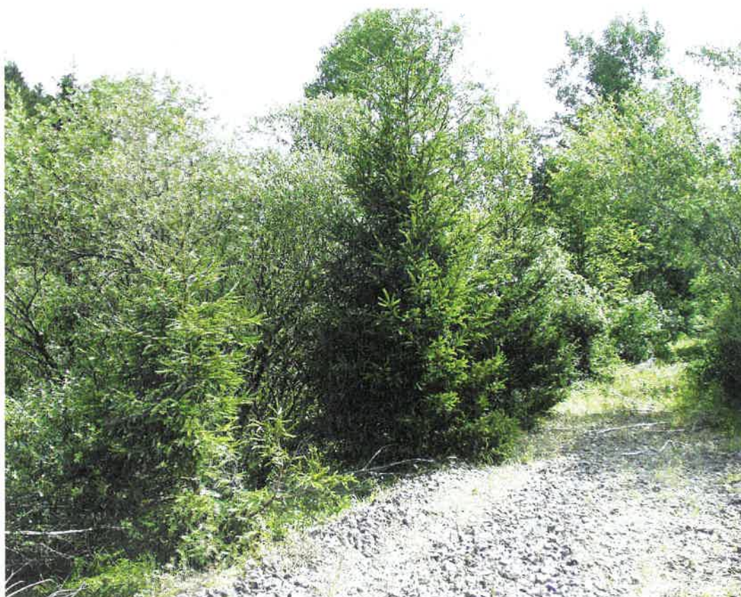
Schotterkörper noch weitestgehend erhalten, Fichtenanflug am oberen Bahndammrand
